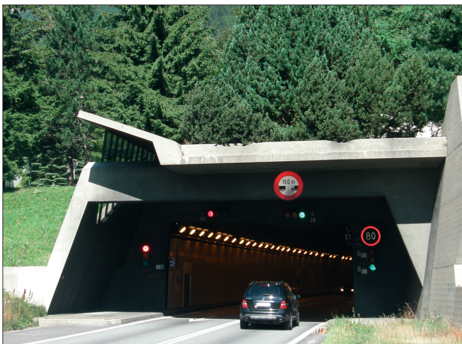
Tunnel du Gothard: les Tessinois ne sont pas les seuls à vouloir un second tube.
